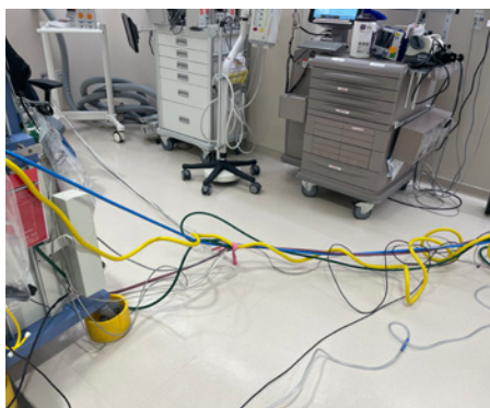
图1: 麻醉机的气体管路、数据电缆、电源线、抽吸管线,有绊倒危险
