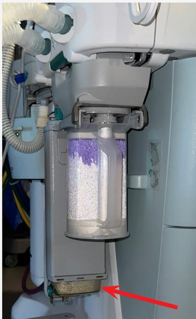
Figure 2 : Position du réservoir du condensateur sur l'Avance CS<sup>2</sup>.
