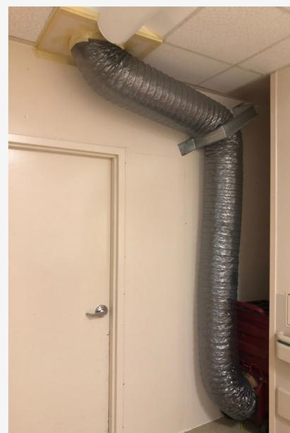
图 2: 前厅内用以制造负压的便携式空气处理器。
