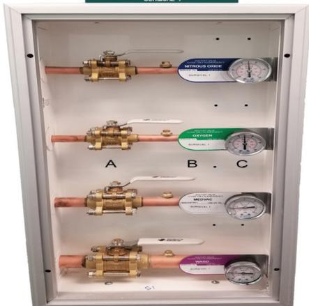
图 2: 区域阀门箱: A - 3 个完整的端口关闭阀, B - 区域阀门组装标签, C - 患者侧真空/压力指示计。
